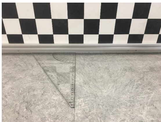
Trouver une ligne perpendiculaire au mur
